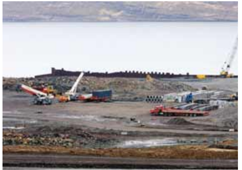
HAFNARFRAMKVÆMDIR Á REYÐARFIRÐI Stálþil hefur verið rekið niður í nýju höfninni á Reyðarfirði. Í sumar verður hægt að skipa byggingarefnum í land.
