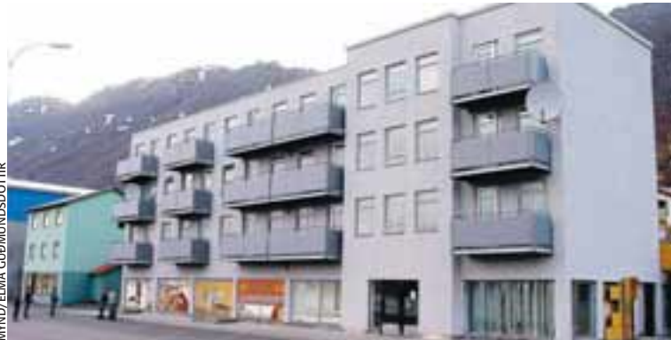
BLOKK Í NESKAUPSTAÐ Svalmar sem konan féll fram af eru á þriðju hæð og um sjö metra fall niður á steinsteypentan kant og stétt. Mildri þykir að konan komst lífs af og hún nær sér trúlega að fullu.
