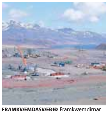
FRAMKVÆMDASVÆÐIÐ Framkvæmdirnar við Fjarðaál ná hámarki sumarið 2006 og þá verða um 1.500 manns í starfsmannahópinu á Haga.
