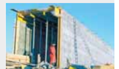
GÖNGIN við Vatnsfellsvirkjun í vinnslu
