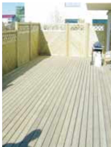
Fura er lögð á pallinn og stólpar reistir fyrir skjólvegg.
