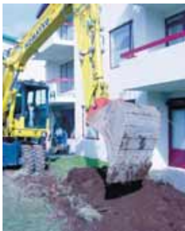
Jarðvegurinn undirbúinn. Grafa þarf fyrir pallinum og fjarlægja allan gróður.
