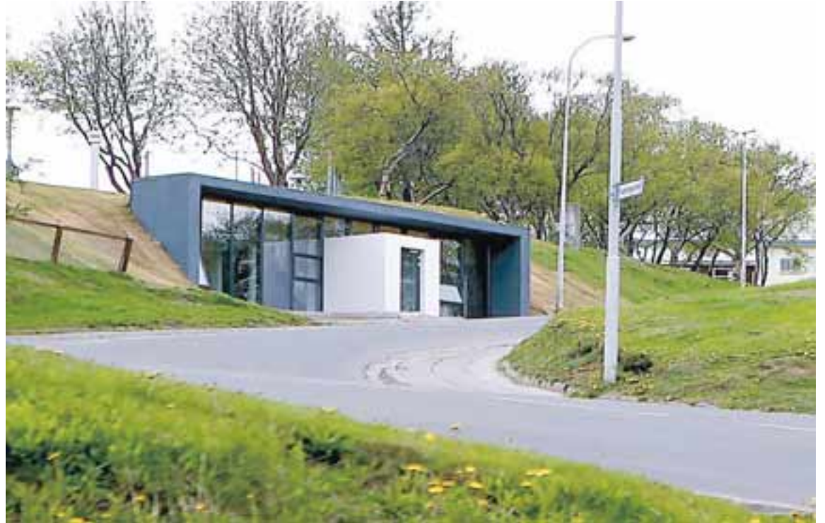
Húsið eins og það er í dag. Grafið var frá framhljóðni og reistur glerveggur sem myndar ramma utan um gamla útvegginn.
