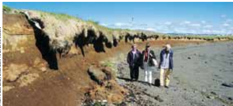
ROFABARD Á KRÍUSANDI Göngustígurinn sem lagður var eftir bökkunum fyrir nokkrum árum er að falla fram af. Það glyttir í jarðvegsdúkinn undir torfunni ef vel er gáð.
