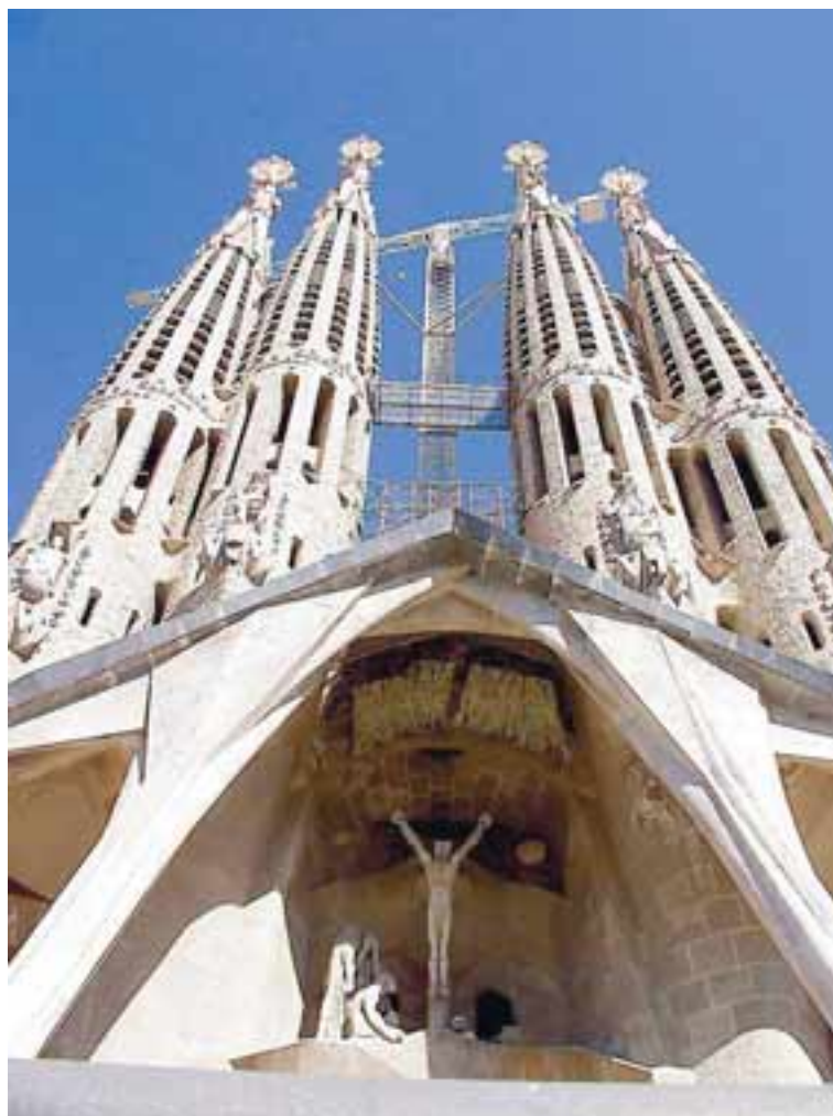
Kirkjan La Sagrada Família er tvímælaust frægasta verk Gaudís og fyrir löngu orðin tákn Barcelona-borgar. Gaudí hóf verkið 1883 og er kirkjan enn í byggingu.
