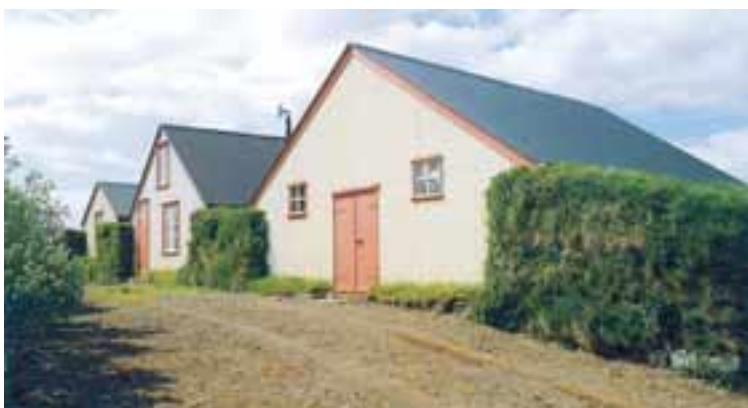
AUSTUR-MEÐALHOLT Torfbærinn á Austur-Meðalholtum í Flóa sem Hannes hefur verið að gera upp síðastliðin tuttugu ár. „Við viljum að þarna verði miðstöð sem varðveitir torfbæjarhefðina með því að rækta handverkið og handverkskunnáttuna með skipulögðum hætti.“
