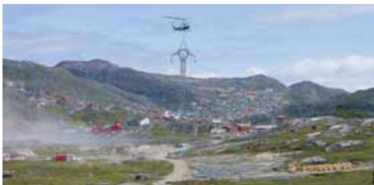
ÞYRLA FLYTUR SPENNUMASTUR Erfitt er að flytja þyngstu hlutina milli vogskorinna og fjöllóttra fjarða Grænlands. Þyrlur eru notaðar til að koma fyrir háspennumóstrum.
