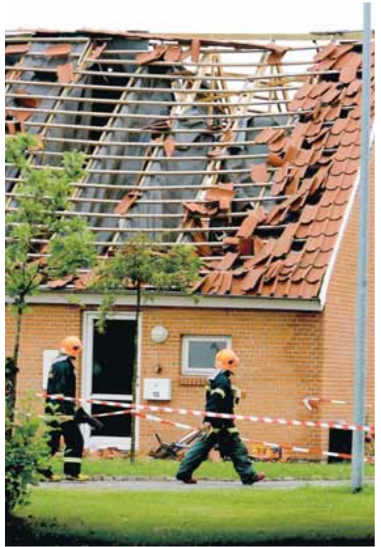
BROMBÆRRANKEN 18 Sprengingin var það öflug að þakið lyftist af húsinu og múrsteinar þeyttust í allar áttir.
