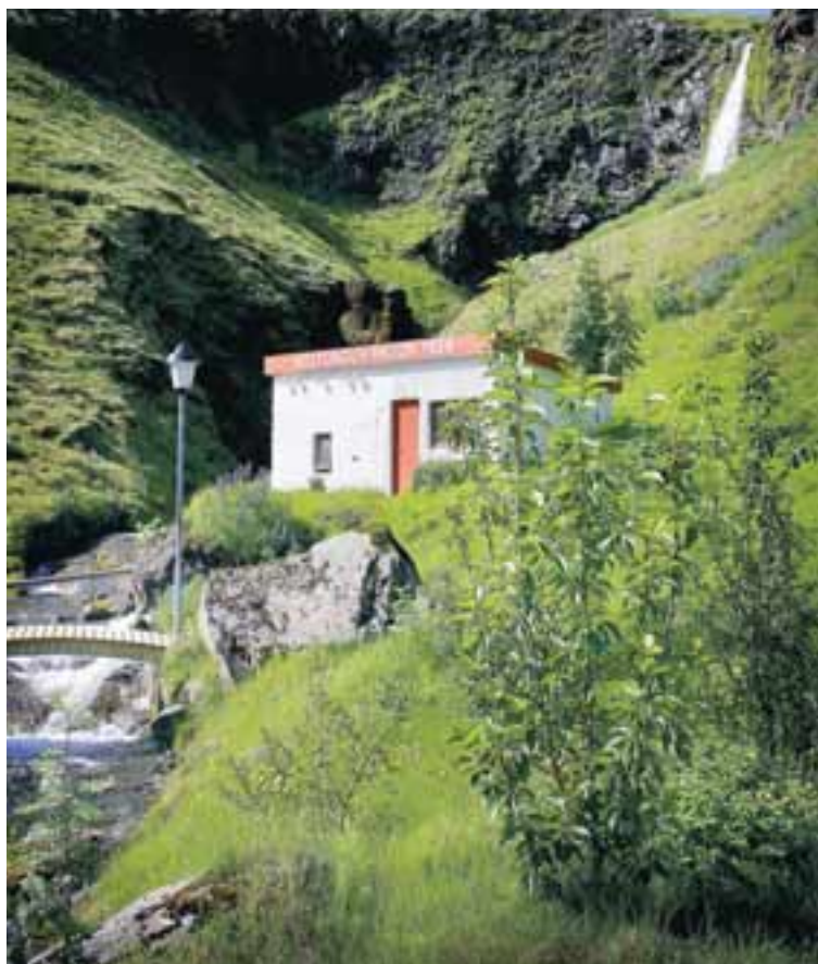
KOLTUNGVIRKJUN Koltunguvirkjun sem sér Þorvaldseyringum fyrir rafmagn er staðsett í unaðsreit fjölskyldunnar og þar hafa þau verið iðin við að gróðursetja trjáplöntum. Koltungufoss sér svo um að úða gróðurinn auk þess sem hann knýr fram raforkuna.
