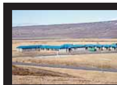
Gömlu Landsvirkjunarhúsin í Hrauneyjum sem nú hafa breyst í lúxushótel.
