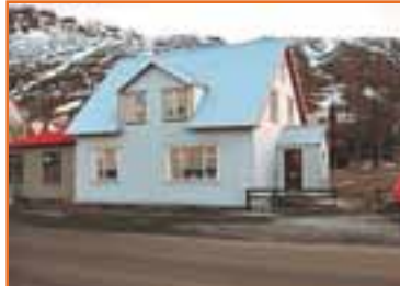
ESKIFJÖRÐUR - ZEUTENSHÚS - LAUST Eitt af elstu og sögufrægustu húsum á Eskifirði, byggt 1870.
