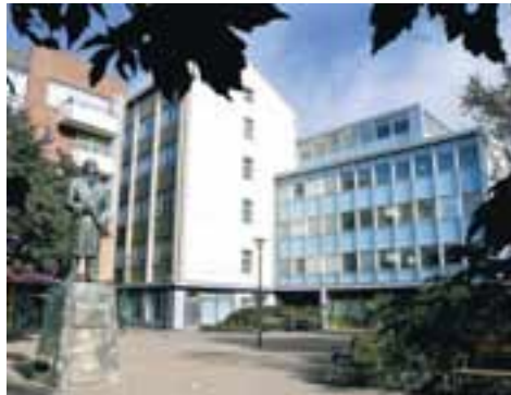
Gamla Landssímahúsið er samsett úr mörgum byggingum frá mismunandi tímum.
