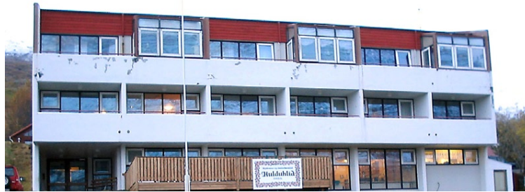
HULDUHLÍÐ Á ESKIFIRÐI Forstöðumaður dvalar- og hjúkrunarheimilisins segir auðvelt að breyta húsnæðinu í hótél en á Eskifirði er ekkert hótél.
