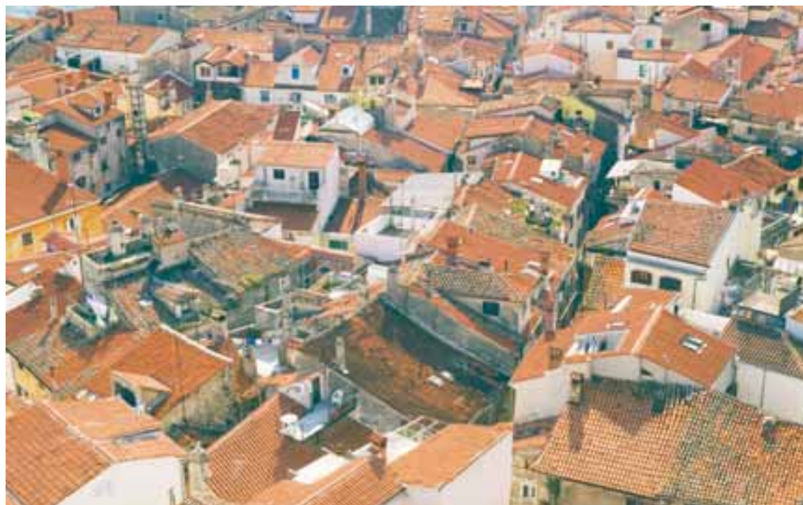
Tígulsteinsþök í þétrri byggði í bænum Pirana í Slóveníu.
