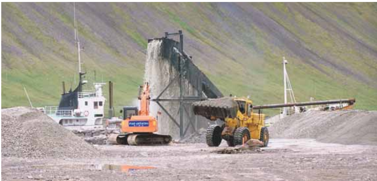
FRAMKVÆMDIR Á BÍLDUDAL Bygging kalkþörungaverksmiðu komst í uppnám eftir að Landsbankinn vildi ekki lána fé til framkvæmdanna.
