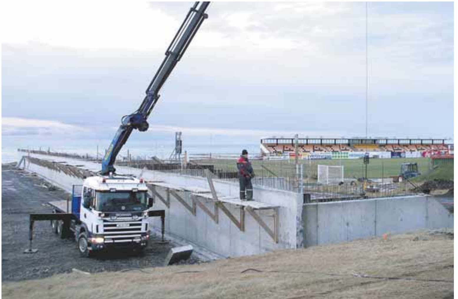
Knattspymuhöll í byggingu á Akranesi. Að sögn Harðar Jóhannessonar hafa framkvæmdir á svæðinu gengið vel.
