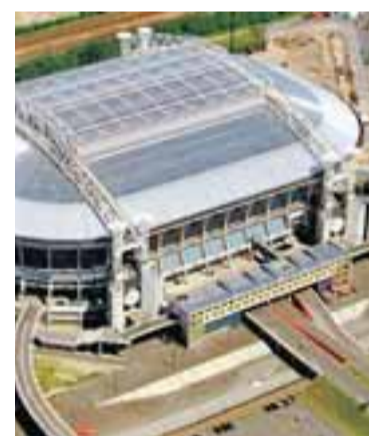
MEKANÍSK HÖNNUN Amsterdam ArenA í Hollandi er gott dæmi um nútíma völl. Hann er yfirbyggður en þó er þakið færanglegt og hægt að opna það ef þannig viðr- ar. Hönnun vallarins er mjög mekanísk eins og sjá má en undir hann ganga hraðbrautir. Sætin inni í höllinni eru mjög litrík og skemmtileg en þau eru rúmlega 50 þúsund talsins.
