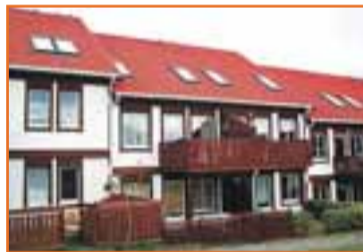
VALLENGI - GÓÐ STAÐSETNING. Björt og rúmgóð 4ra herbergja íbúð á 2 hæðum í vinsælu PERMAFORM-húsi. Óil þjónusta í göngufæri. 4810
