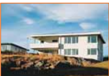
GNÍPUHEIÐI - NÝBYGGING 218 fm einbýlishúsi með tvöföldum 39 fm bílskúr við Gnípuheiði. Glæsilegt útsýni. Tilbúð til innréttinga. Á efri hæð eru 2 stofur, eldhús og gestasnyrtning. Á neðri hæð eru 4 herbergi, sjónvarpskáli, baðherbergi, þvottahús og geymsla. 4816
