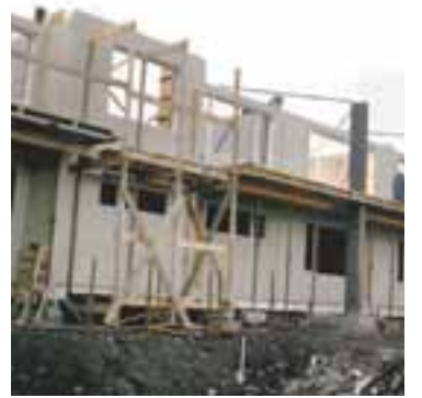
Í BYGGINGU Starfsmannaleigurnar hafa einkum útvegað iðnaðarmenn og verkamenn í byggingavinnu. FRÉTTABLAÐIÐ/GVA
