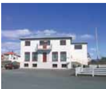
Rauða húsið á Eyrarbakka.
