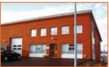
DALVEGUR - KÓPAVOGI Nýlegt 304 fm atvinnuhúsnæði á tveimur hæðum. Á jarðhæð eru 2 salir, snyrting, eldhús og lag-erhúsnæði með innkeyrsluhurð. Á efri hæð er salur með snyrtingu og kaffiaðstöðu. V. 46,5 m. 4835
