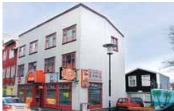
LAUGAVEGUR 19 OG 19B OG 17 BAKHÚS Þessi hús voru keypt fyrir samtals 194 milljónir en uppbygging á svæðinu bíður þess að eigendur húseigna komi sér saman um hana.
