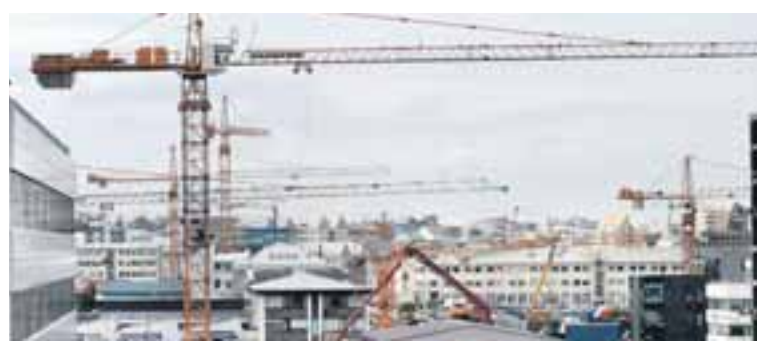
KRANI VIÐ KRANA Miklar byggingaframkvæmdir eru í Borgartúni.
