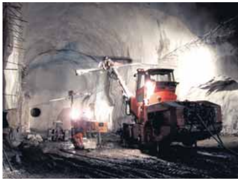
Bygging stöðvarhúss við Kárahnjúka.
