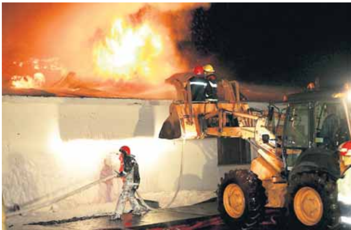
FRYSTIHÚSIÐ SKÍÐLOGAR Eldurinn kviknaði í elsta hluta frystihússins. Þar eru birgðageymslur þess og var þak hússins hrunið þegar Fréttablaðið fór í prentun. Íbúðarhús höfðu verið rýmd vegna sprengihættu.
