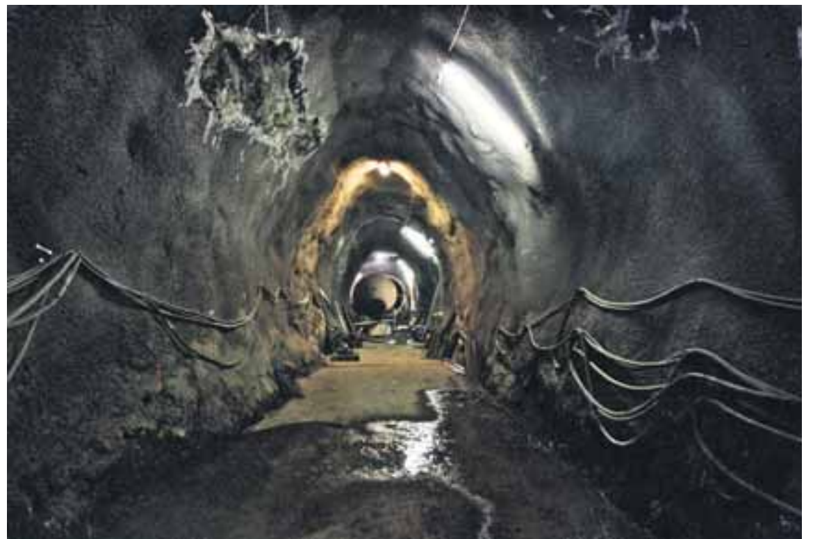
VATNSVEGUR ORKUNNAR Séð inn í göngin Distributor-1 þar sem austfirskur vatnskraftur mun fossa strítt inn um rör til virkjunarinnar.
