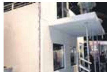
Smellinn hf. sýndi meðal annars þessar forsteyptu veggjeningar. Með þeim tekur 2-3 daga að reisa vegg í 200 fermetra einbýlishúsi.
