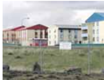
Á VARNARLIÐSSVÆÐINU Verktakar hafa sinnt viðhaldi og framkvæmdum við mannvirki á vallarsvæðinu. FRÉTTABLAÐIÐ/PIJTUR
