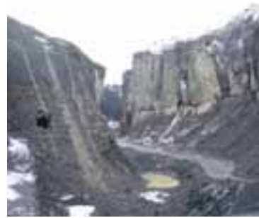
ÚR HAFRAHVAMMSGLJÚFRI Banaslysið varð 15. mars 2004. Samtals hafa orðið þrjú banaslys á framkvæmdasvæðinu við Kárahnjúka.
