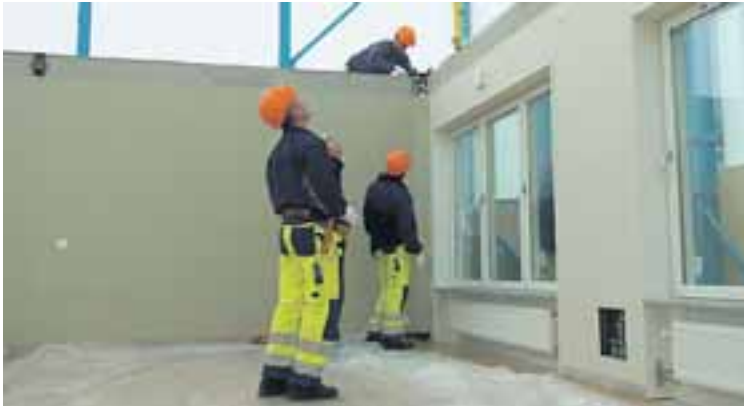
HÚSI SMELT SAMAN Sænskir verkamenn við störf að setja saman verksmiðjuframleidda íbúðablokk. LIÓSMYND/NCC AB
