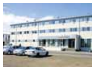
Hótel Hérað á Egilsstöðum er eitt þeirra hótela sem hafa aukið nýtingu sína.
