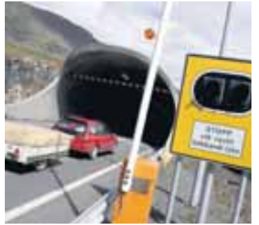
HVALFJARÐARGÖNGIN Viðskiptaráð telur Hvalfjarðargöngin gott dæmi um framkvæmd sem falin hefur verið einkaaðilum og heppnast framar vonum.
