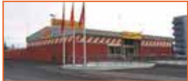
VESTURBERG - MÖGULEIKAR Gott 517 fm verslunar-og lagerhúsnæði á einni hæð á góðum stað í Breiðholti. Verslun, lager, skrifstofa, kaffistofa, snyrtingar, kælar og frystar. Húsnæðið er í góðu standi og að utan húsið klætt með Steni og áll. Malbikuð bílastæði. Tæp 4 ár eru eftir af góðum leigusamningi. Mikil möguleikar. V. 68,9 m. 5044
