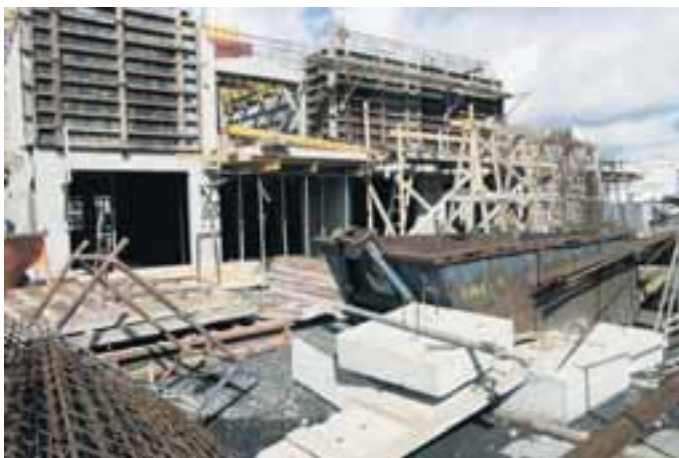
Framkvæmdir eru nú í fullum gangi í Skipholti en þær hófust í janúar. Þrátt fyrir umfang þeirra hafa þær ekki raskað umferðinni við götuna.
