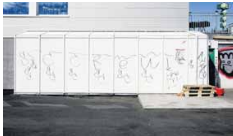
GRÍMSBÆR Veggir hans eru oft útkrotaðir og námu skemmdir á byggingunni yfir hálfri milljón króna á síðasta ári. Rætt hefur verið um að setja upp eftirlitsmyndavélar við húsið.
