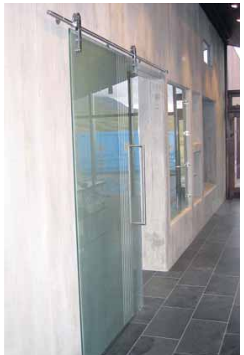
Steyptur veggur í sumarhúsi hannaður af Steinari Sigurðssyni, arkitekt FAÍ hjá VA arkitektum ehf. Verktaki: Trésmiðja Sigurðar Runólfssonar.
