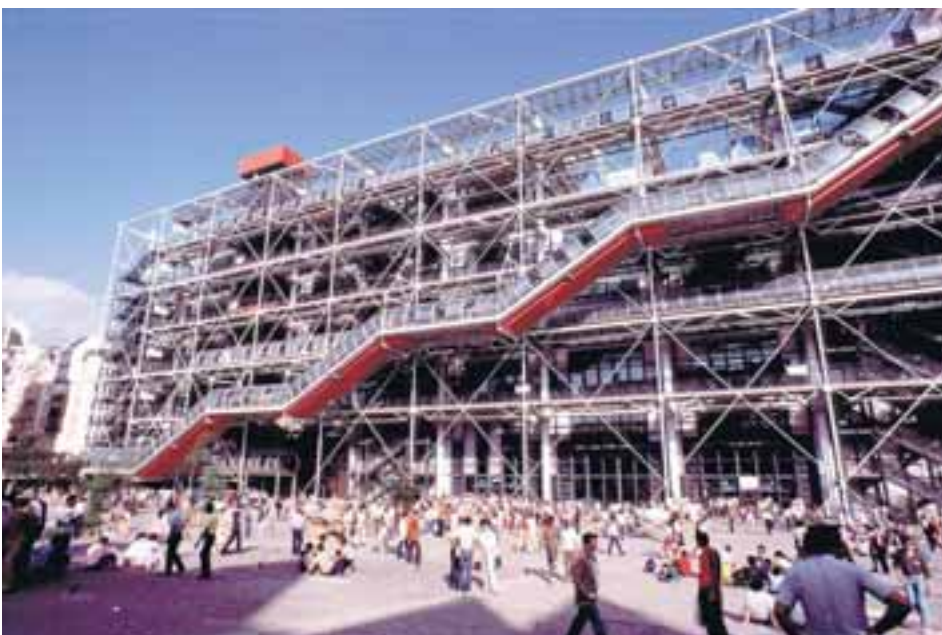
Aðalhönnuður Pompidou-safnsins í París er Renzo Piano. Húsið er á röngunni, ef svo má segja, en allar lagdir og burðargrindur eru utan á húsinu. Loftræstingarrörin eru blá, vatnslagnir grænar og rafmagnslagnir gular.
