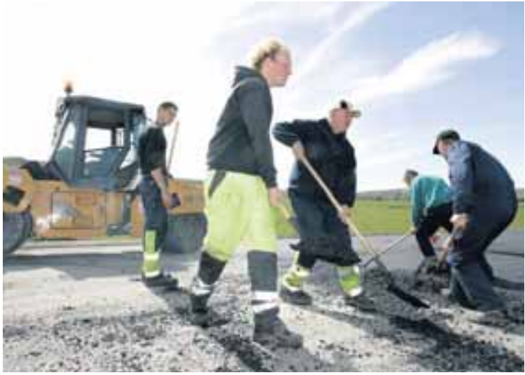
Bílnir eru ekkert sérstaklega sveigjanlegir og þar sem þeir ná ekki að slétta úr malbikinu dugar ekkert annað en handafl til. Það getur verið vandasamt verk, en auðveldast þegar margir leggjast á eitt til að klára það.
