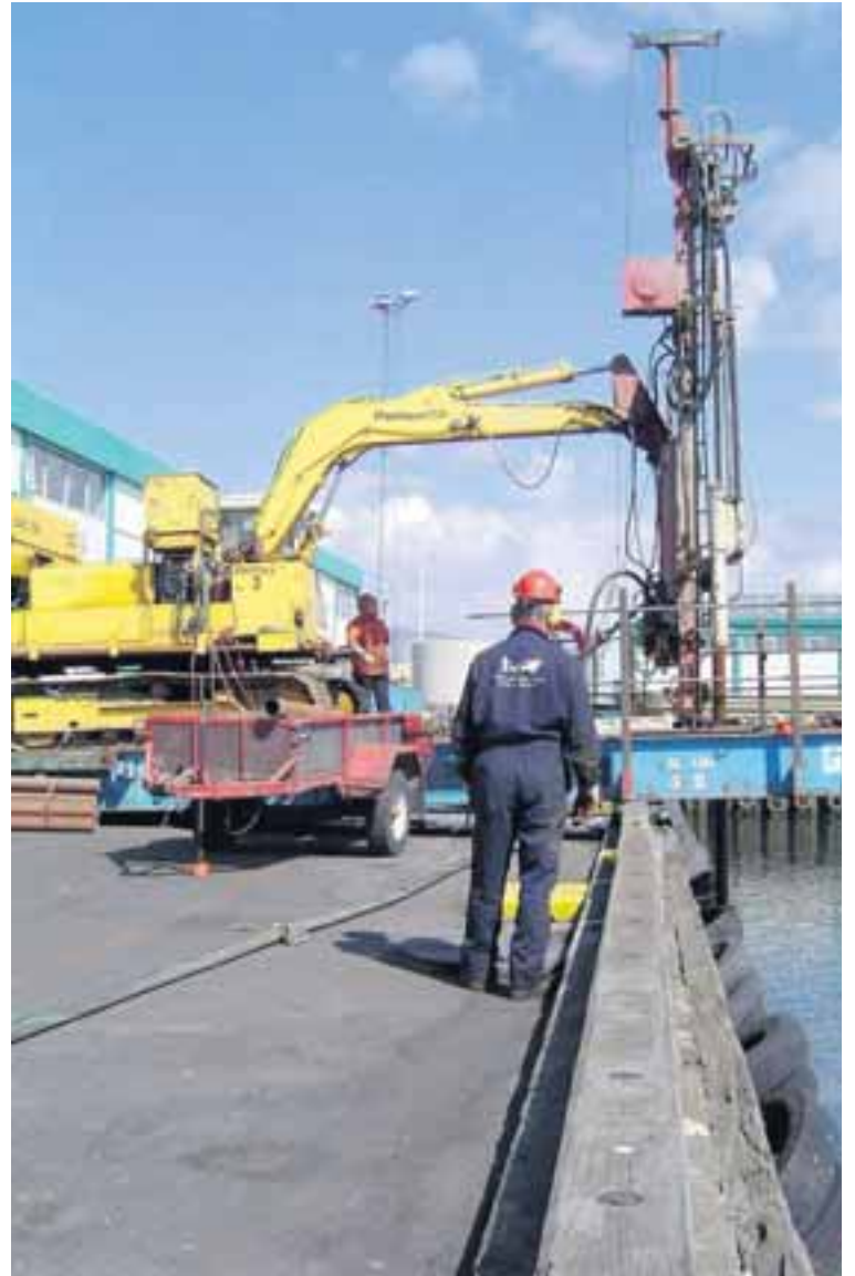
Rannsóknabor við Reykjavíkurbíó, þar sem víðamiklar rannsóknir á jarðvegi voru gerðar vegna byggingar á tónlistarhúsi.
