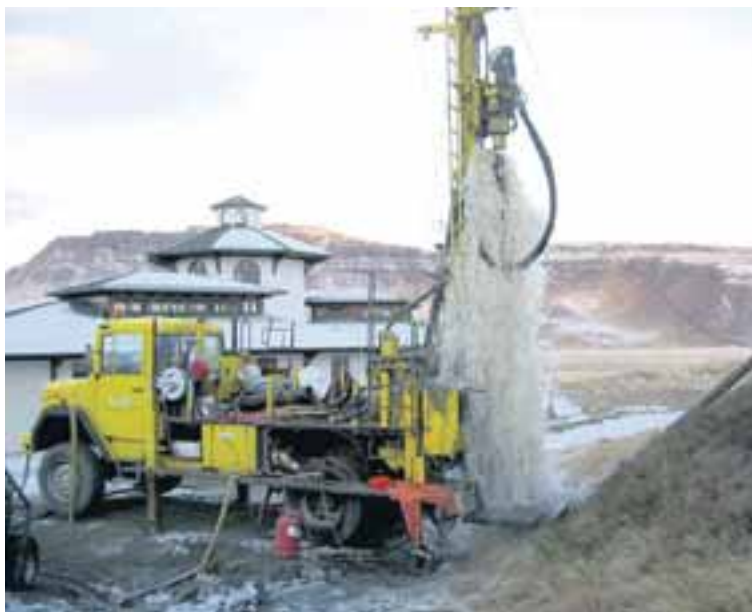
Hér sjást starfsmenn Ræktunarsambands Flóa og Skeiða nota stærsta bor fyrirtækisins, Trölla, við vatnsborun.
