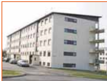
SAFAMÝRI - JARÐHÆÐ Rúmgóð tveggja herbergja íbúð á jarðhæð sem skiptist í: Hol, stofu, svefnherbergi, baðherbergi, eldhús og sérgymsla innan íbúðar. Móguleiki á sérgarði. V. 15,9 m. 5063
