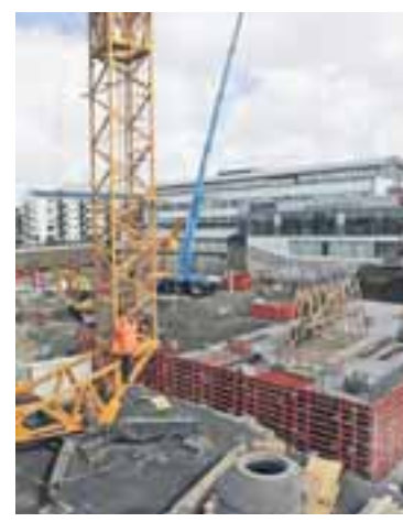
Eins og sést á þessari mynd miðar framkvæmdum vel.
