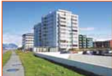
GRANDAVEGUR - M.BÍLAGEYMSLU Íbúð fyrir eldri borgara. Glæsilega 3ja herbergja íbúð á 8. hæð. Yfirbyggðar svalir. Stæði í bílageymslu. Stórfenglegt útsýni út á Faxaflóann og víðar. Tvær lyftur. Íbúðin, að meðtöldum yfirbyggðum svölum, er u.þ.b. 94 fm. LAUS STRAX. V. 28,8 m. 5137
