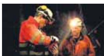
SPRENGING UNDIRBÚIN Fyrsti gegnumsláttur aðrennslisganga Kárahnjúkavirkjunar var í gærmorgun.
