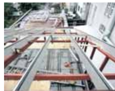
KAFFIHÚS Framkvæmdir eru á fullu við kaffihús Pennans-Eymundssonar.
