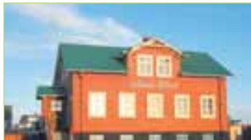
RAUÐA HÚSIÐ Á EYRARBAKKA
