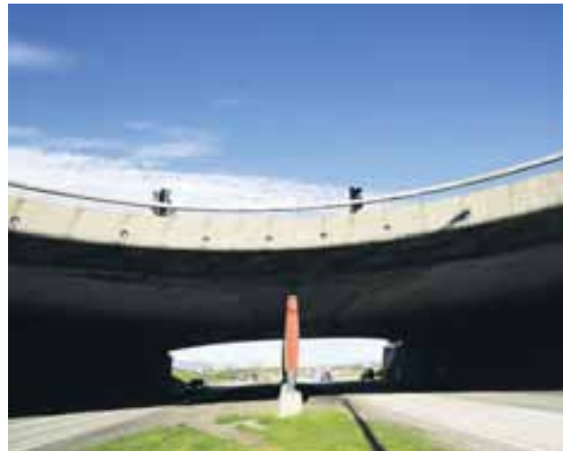
BRÚIN Á HÖFÐABAKKA VIÐ VESTURLANDSVEG Reynt var að fella brúna að umhverfinu. Handrið hennar og neðri kantur mynda hluta af stoðveggjunum. Sporðskjuleg op eru í endastöplunum sem lýsast upp í myrkri. Vegna grannra stálsúla virðist rýmra undir henni.
