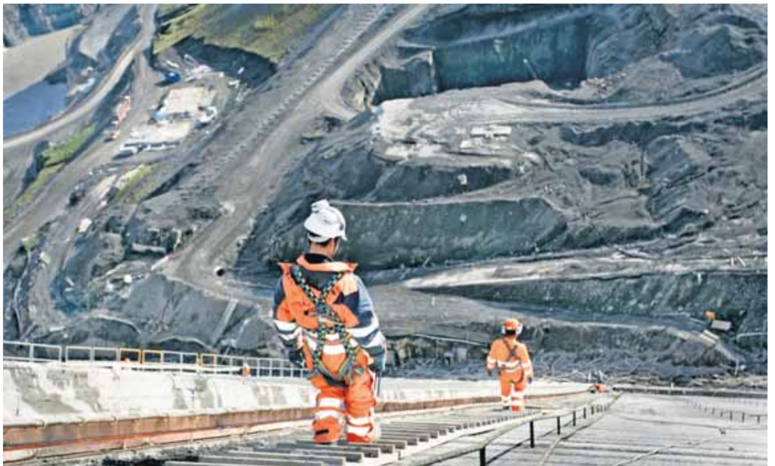
GENGIÐ NIÐUR STÍFLUVEGGINN Kínverskir verkamenn ganga niður steiptan stífluvegg Kárahnjúkavirkjunar, en hann er með 35 gráðu halla. Málefni Kárahnjúkavirkjunar hafa verið mikið í umræðunni undanfarnar vikur og hafa sérfræðingar deilt um styrk stíflunnar og hvort hún þöli hugsanlegar jarðhreyfingar.
