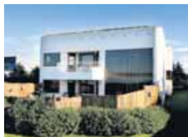
Húsið þarfnáðist algjörar yfirhalingar þar sem það var illa farið af steypuskemmdum og var nánast múrað upp á nýtt.
