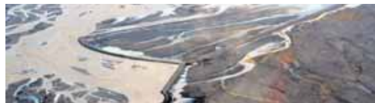
FRÁ SKEIÐARÁ Varnargarðurinn lét verulega á sjá eftir ágang Skeiðarár á dögunum, eins og hér sést. Snarræði vélamanns kom í veg fyrir að áin næði í gegn og ylli tjóni á veginum.
