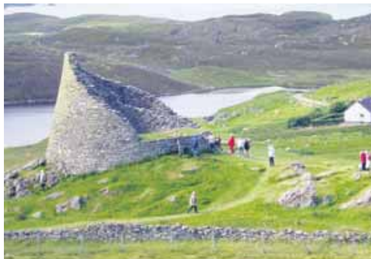
Brock eða borg, rúst af fornu steinhlöðnu fjölbýlishúsi, 2-3 hæðir með tvöföldum útvegg og göngum þar milli hæða á Lewis.
