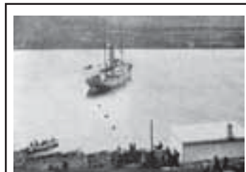
LÍNAN LÖGÐ Lagning fyrstu símalínunnar milli Seyðisfjarðar og Reykjavíkur á fjórum mánuðum árið 1906 er eitt af mestu verkfræðiafrekum Íslandssögunnar.
