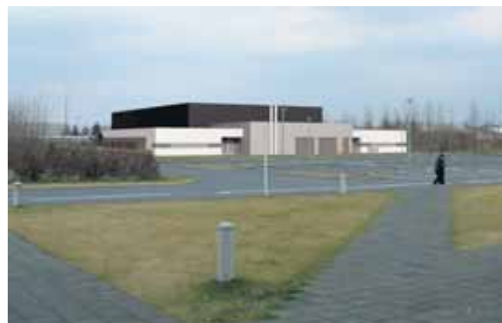
Frá Selfossi. Íþróttahús og viðbótarkennsluhúsnæði við Fjölbautaskóla Suðurlands.
