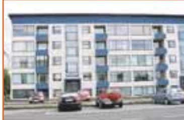
BÓLSTAÐARHLÍÐ 3ja herbergja 90 fm íbúð í kjallara í fjölbýlishúsi. V. 18,5 m. 5143
