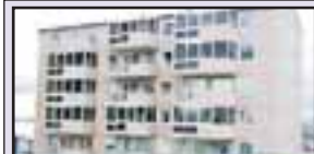
HÁHOLT - ÚTSÝNI Falleg og björt 76,2 fm íbúð á 2. hæð í lyftuhúsi ásamt stæði í bílagemymslu. Verð 17,6 millj. 9637
