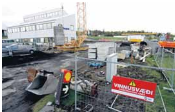
Byggingaframkvæmdir eru nýhafnar á viðbyggingu Heimsferða.
