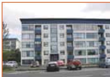
BÓLSTAÐARHLÍÐ 3ja herbergja 90 fm íbúð í kjallara í fjölbýlishúsi. V. 18,5 m. 5143
