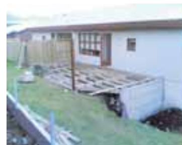
Mynd 3. Föstudaginn 5. ágúst var steypu- og smíðavinna eitthvað á veg komin.
