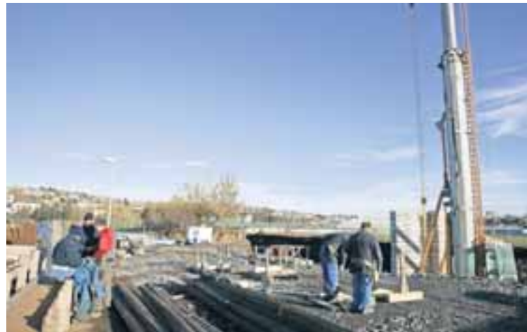
Framkvæmdir eru hafnar við byggingu nýrrar stúku við Kópavogsvöll.
