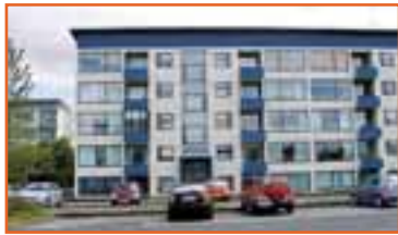
BÓLSTAÐARHLÍÐ 3ja herbergja 90 fm íbúð í kjallara í fjölbýlishúsi. V. 18,5 m. 5143
