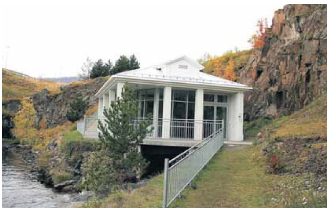
Stöðvarhúsið við Glerá er 80 fermetrar að stærð og byggt á grunni eldra húss.
