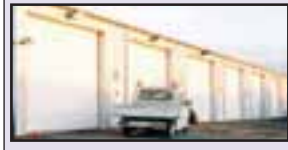
RAÐHELLA - HFJ. 109,2 fm bíl og 50 fm milliloft (íbúð í dag). Góð innkeyrsluhurð, góð lofthæð. Verð 18,5 millj.
