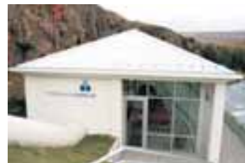
Glerveggur er innan við steinsteyptar súlur á suður, austur og hluta af vesturvegg.
