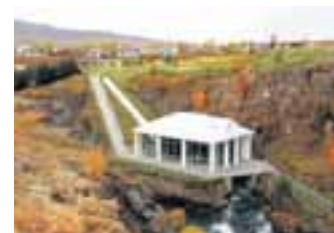
Það var frekar þröngt um á byggingarsvæðinu og húsið vel falið þótt það sé inni í bæ á Akureyri.
